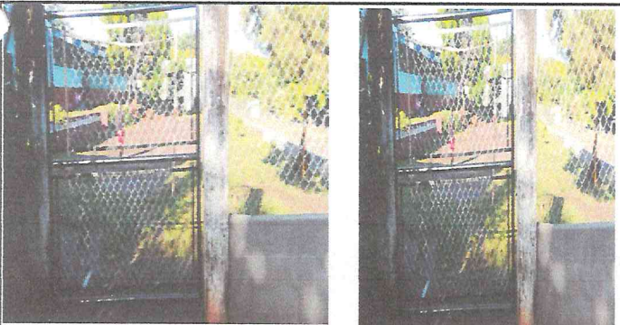
Foto 5: Colocación de portón nuevo en la escuela
