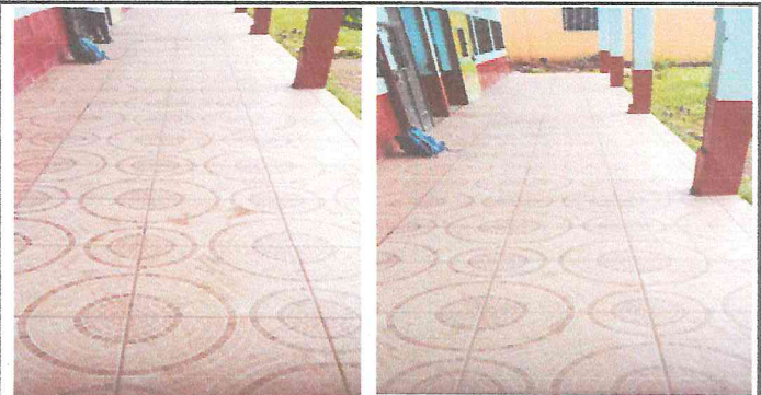
Foto 2: Finalizado la colocacion de piso del corredor de salones
